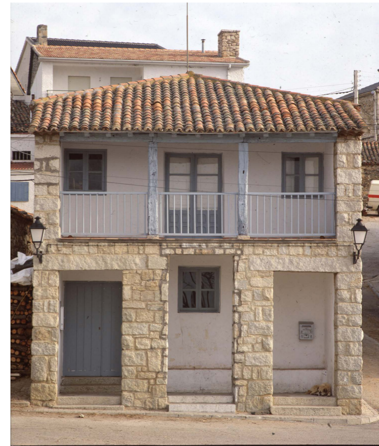
Reforma del Ayuntamiento, 1987. Fuente: Centro de Documentación de Medio Ambiente y Ordenación del Territorio.
