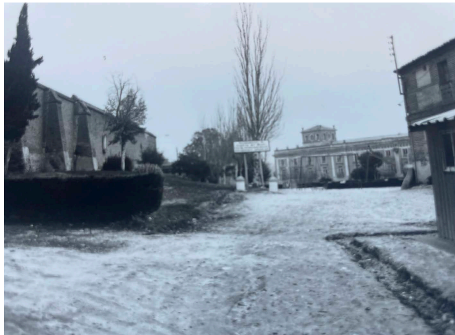
Vista Boadilla, al fondo Palacio del Infante don Luis. En: Directrices para la protección del patrimonio edificado y urbanístico de los cascos antiguos de la Comunidad Autónoma de Madrid, 1985. Fuente: Centro de Documentación de Medio Ambiente y Ordenación del Territorio.
