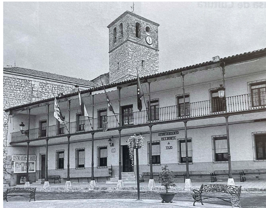
Nuevo Ayuntamiento, año 2000. Fotografía: José Manuel Ablanado. Fuente: Centro de Documentación de Medio Ambiente y Ordenación del Territorio.
