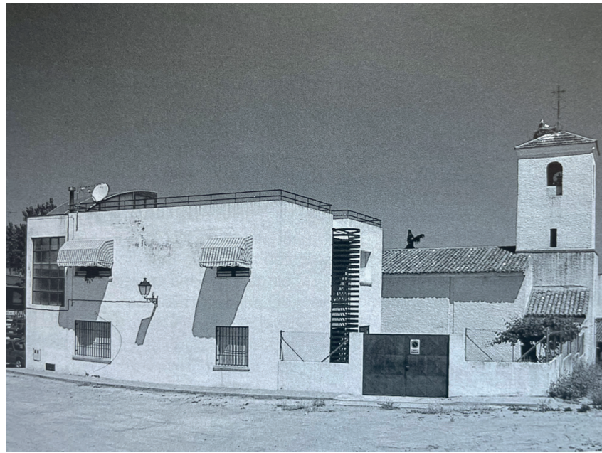
Iglesia y casa del párroco demolidas para construcción de área de centralidad. Fotografía: José Manuel Ablanado. En: Arquitectura y desarrollo, 2000. Fuente: Centro de Documentación de Medio Ambiente y Ordenación del Territorio.
