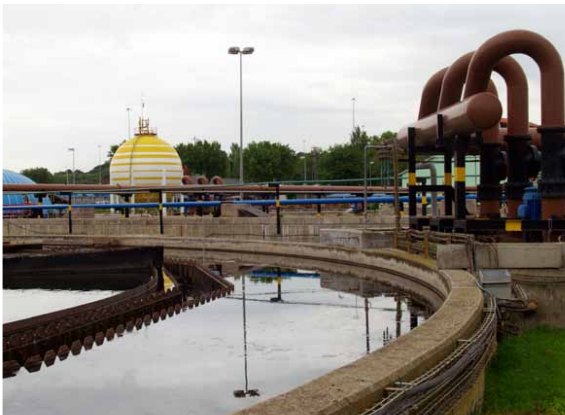
Imagen de los decantadores secundarios faz en la Depuradora de los Viveros de la Villa de Madrid.
