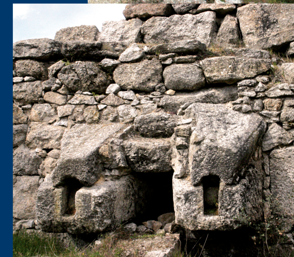
Cárabo. Salida de agua
