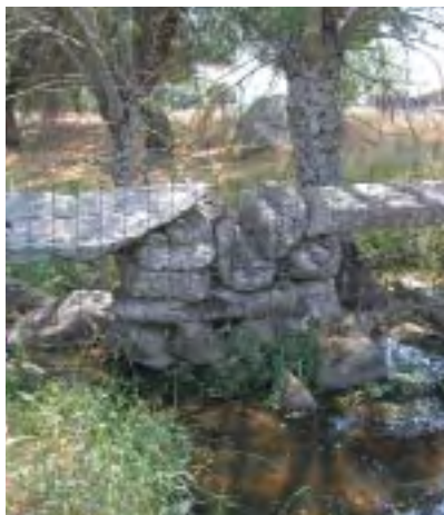
Puente sobre el arroyo del Pradejón
