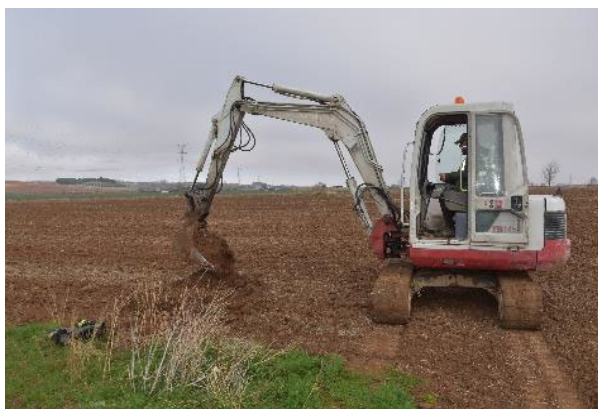
Excavación en P-3.
