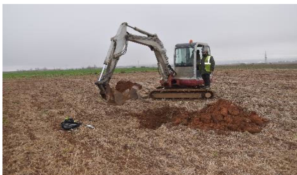
Excavación en P-7.
