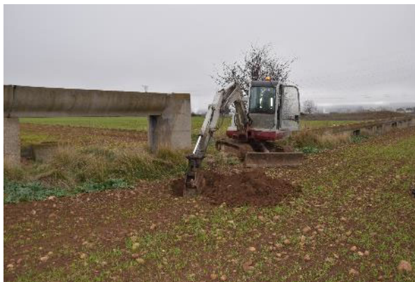
Excavación en P-11.
