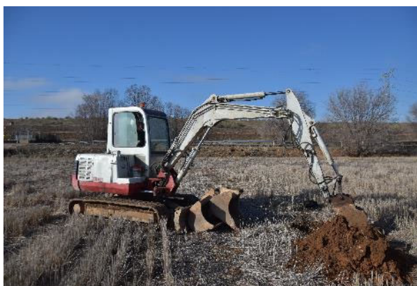
Excavación en P-1.
