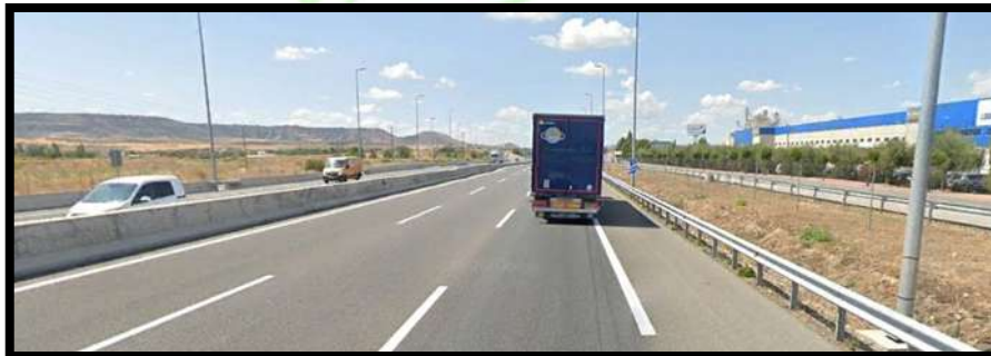
Figura 6.17 Autopista A2 a su paso por Alcalá de Henares
