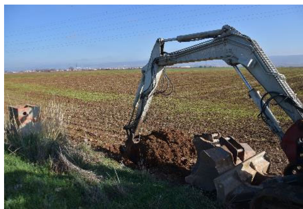
Excavación en P-2.
