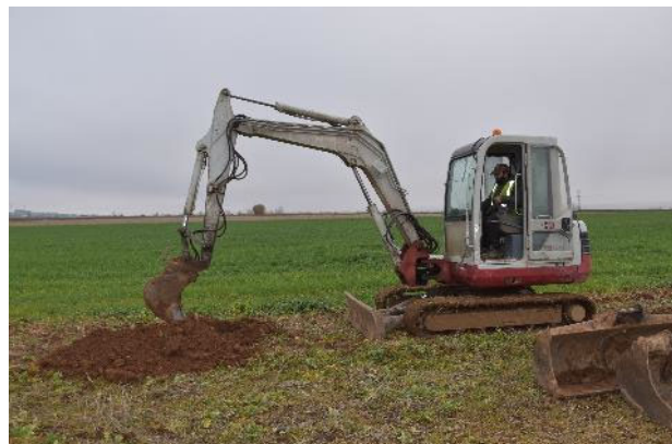
Excavación en P-6.
