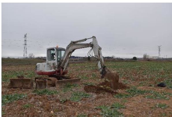
Excavación en P-9.
