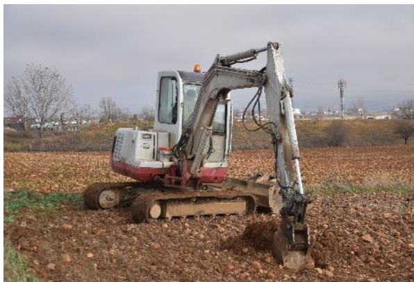
Excavación en P-5.
