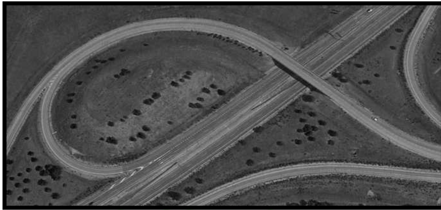
Figura 6.16 Autopista Radial 2, R-2 o Autopista del Henares
