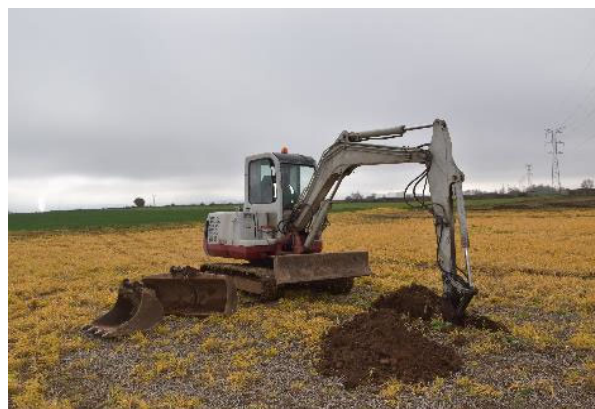
Excavación en P-4.
