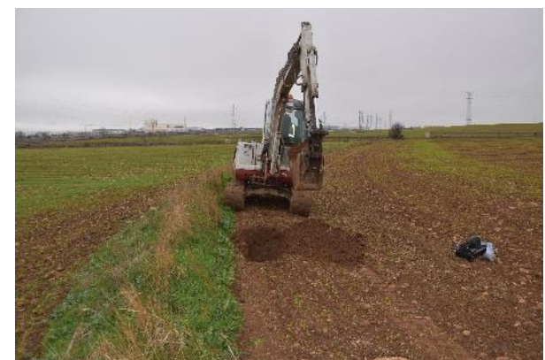
Excavación en P-10.
