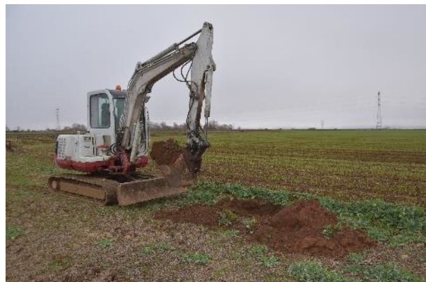
Excavación en P-12.
