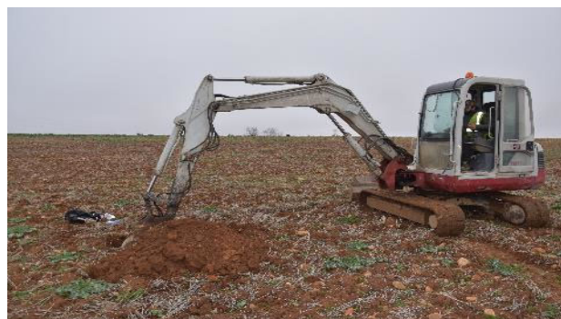
Excavación en P-8.
