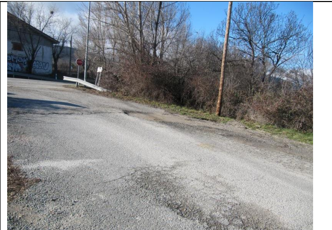
Conexión del camino de acceso a la urbanización El Verdugal con la M-604
