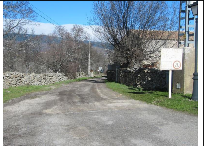
Zona inicial del acceso a la urbanización Las Pajarillas
