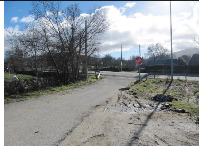
Conexión del camino de acceso a la urbanización Las Pajarillas con la M-604
