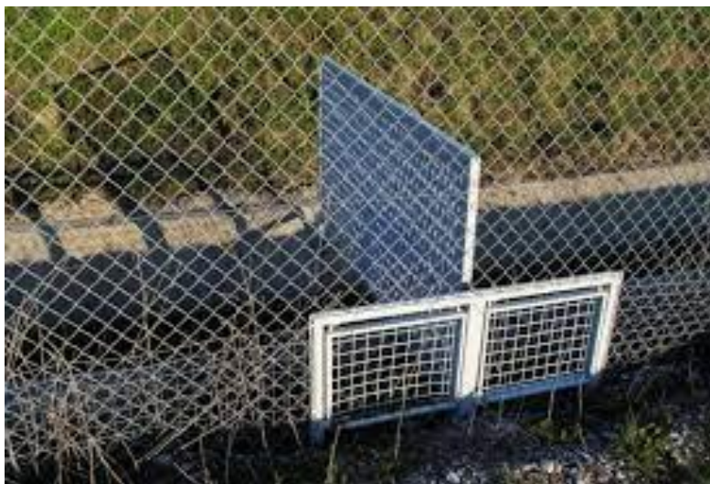
Figura 11.2.1.2.1.- Vallado de escape de fauna tipo. Basculante 2 hojas
