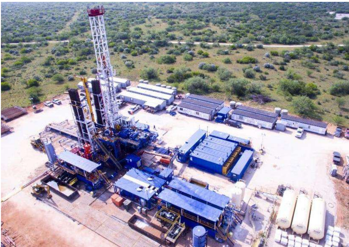
Figura 8. Plataforma de perforación
