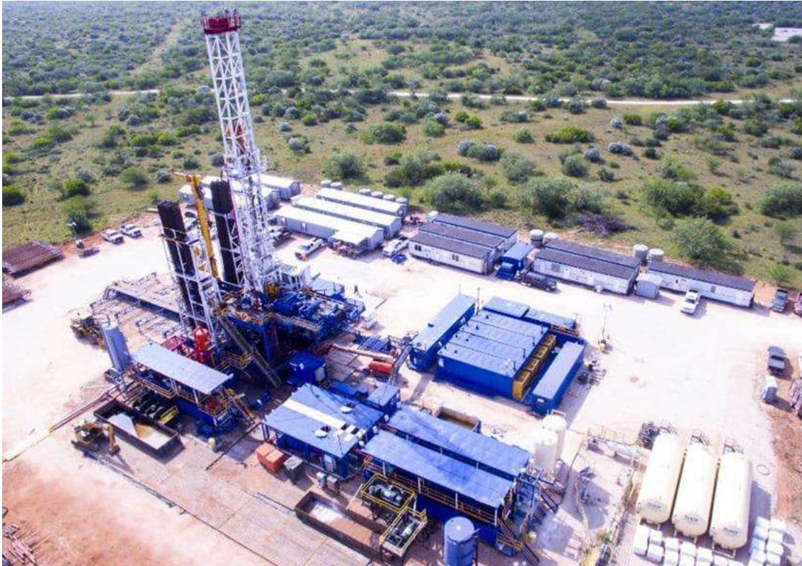
Figura 11. Plataforma de perforación
