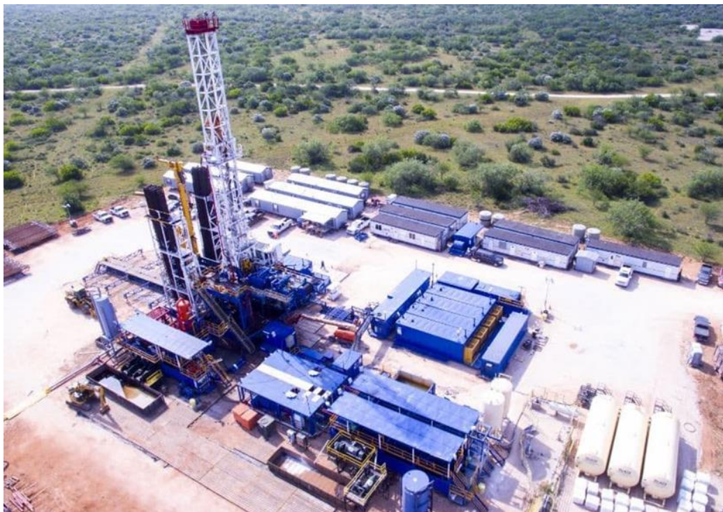
Figura 10. Prototipo de plataforma de perforación.
