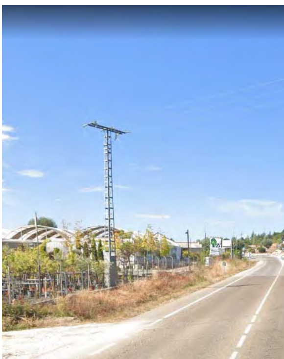
Fotografías 5 y 6. Cruce carretera M-508 y apoyo nº 352 de la línea aérea a desmontar. Calle Real donde discurre L1 en subterráneo en canalización entubada.
