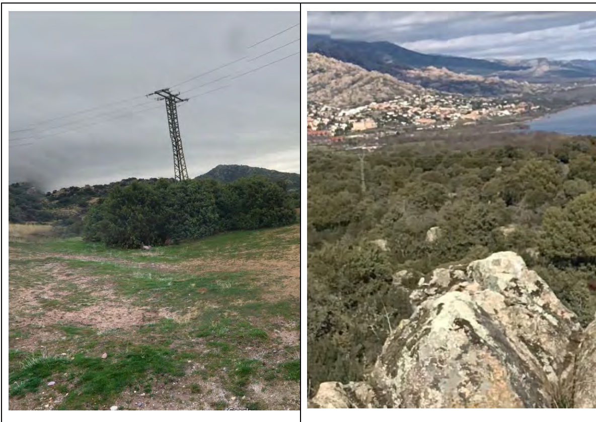
Fotografía 15 y 16. Tramo de línea adecuación avifauna en el Chaparral de la Tejera.
