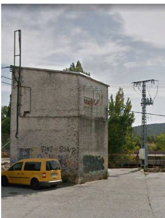
Fotografías 3 y 4. Inicio L1 en CT RIO-MANZA (111210675) y apoyo nº 351 a eliminar.
