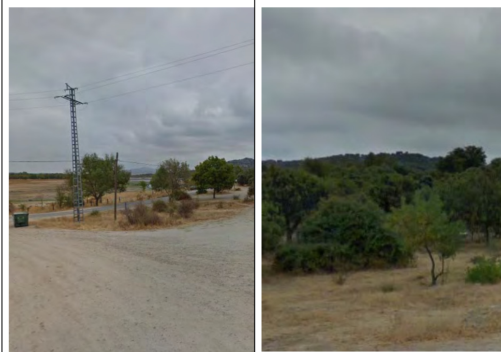
Fotografía 11 y 12. Apoyo nº 367 existente, inicio tramo L3 subterráneo. Detalle de arbolado en el entorno de los tramos L4 y L5.
