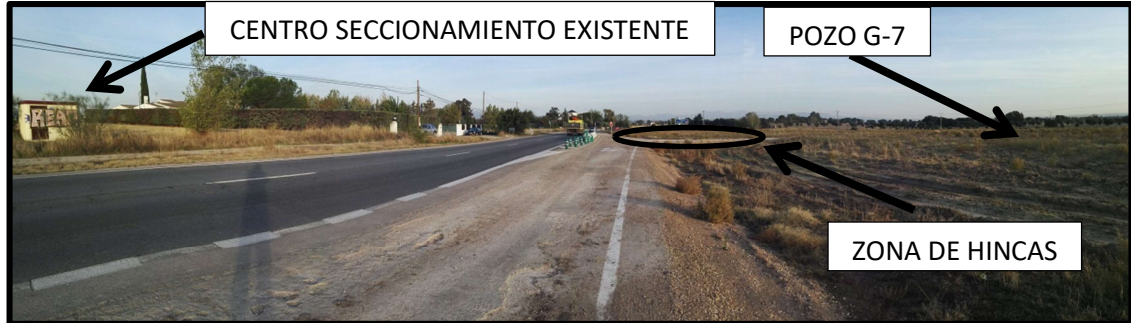
Vista general de zona de proyecto
