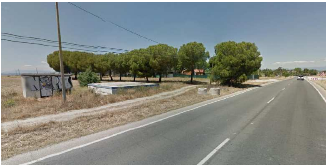
Figura 3: Cámara de Aducción y pozos de registro de CYII.
