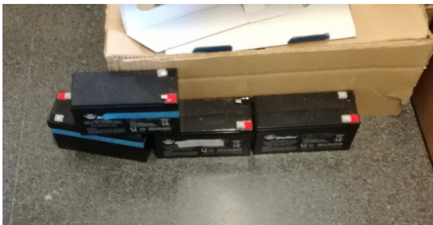
BATERÍAS CENTRALITAS QUE SE ESTÁN CAMBIANDO
