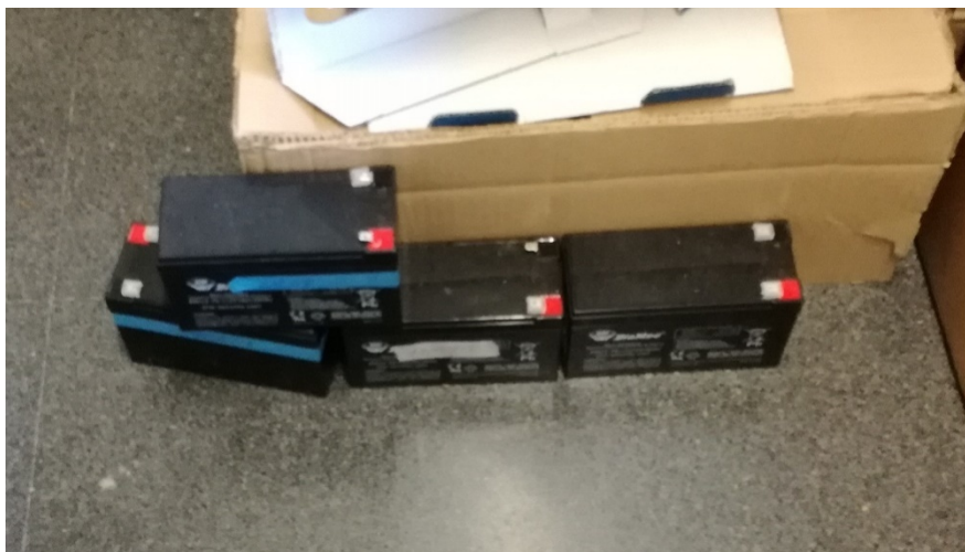
BATERÍAS CENTRALITAS QUE SE ESTÁN CAMBIANDO
