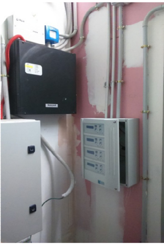
FOTO 7: NUEVO CABLEADO DETECTORES DE CO.
