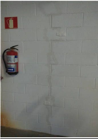
FOTO 5: REPARACION GRIETA Y TESTIGOS.
