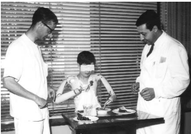
Doctores González Espejo y Pérez Sánchez con paciente con desarticulación bilateral hombros (por electrocución), utilizando prótesis accionadas por energía externa (dióxido de carbono). (Año 1966).
