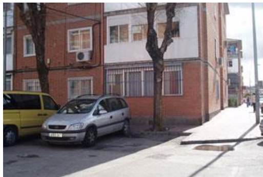
Piso supervisado 3 de Alcalá
