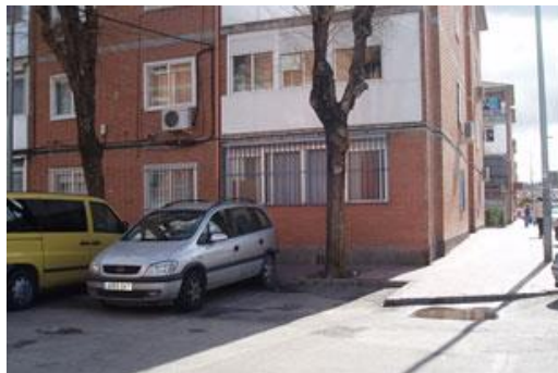
Piso supervisado 3 de Alcalá
