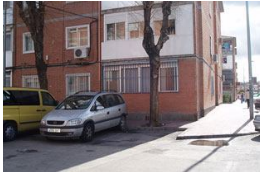
Piso supervisado 3 de Alcalá
