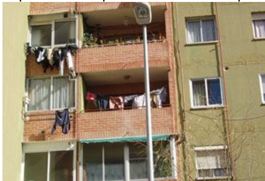
Piso Escuela de Alcalá de Henares
