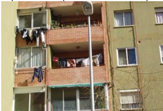
Piso Escuela de Alcalá de Henares
