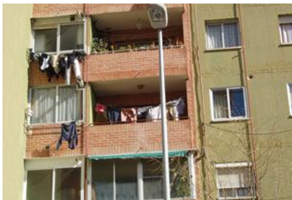
Piso Escuela de Alcalá de Henares
