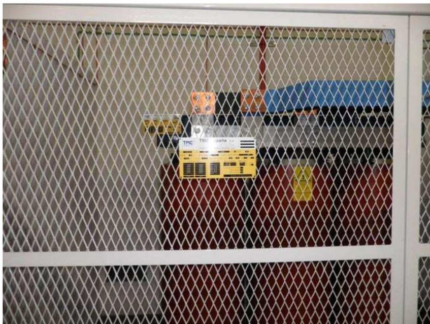
Transformador seco de 1.600 kVA
