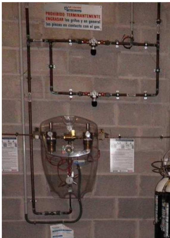
Tuberías en Rampa de Gases Medicinales
