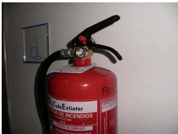
Extintor 204 – No marca presión en manómetro
