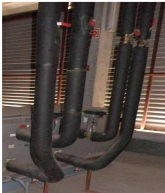
Aislamiento Calorifugado tipo Armaflex
