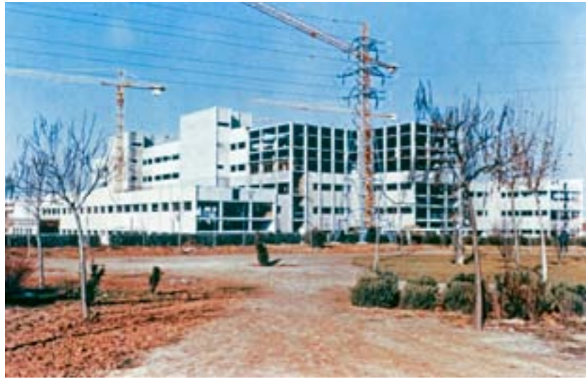
Vista de las obras de construcción del Hospital junto a la carretera de Toledo.
