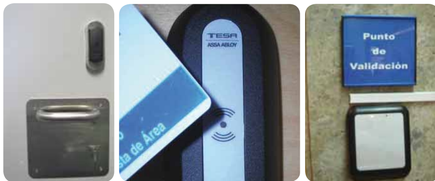
1. Puerta con dispositivo electrónico. 2. Lector de tarjeta. 3. Punto de Validación.
