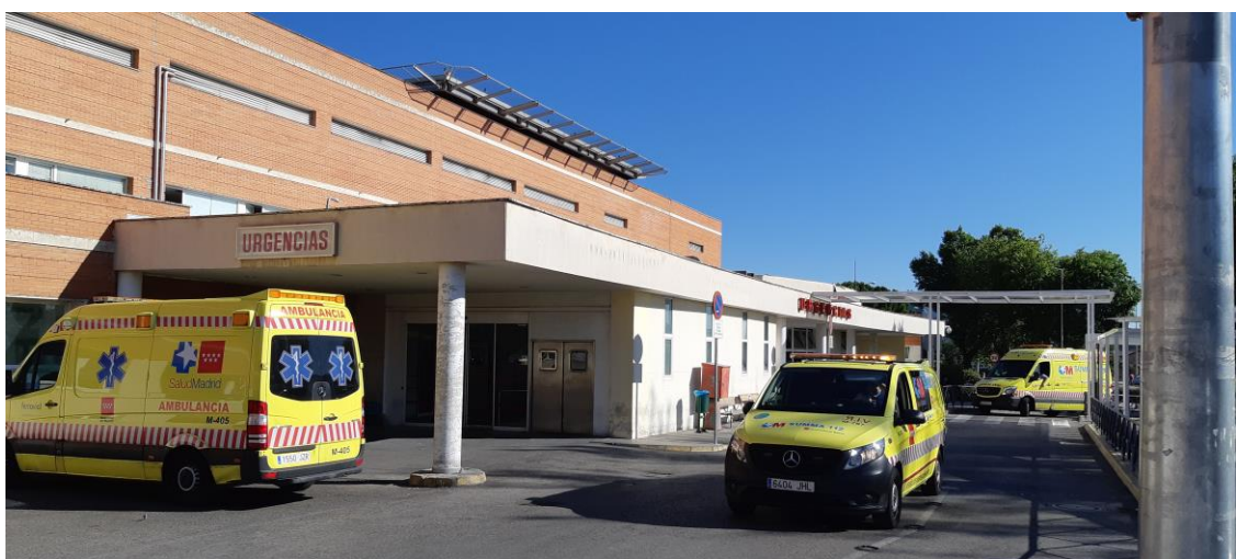
Urgencias Generales del Hospital Universitario 12 de Octubre
