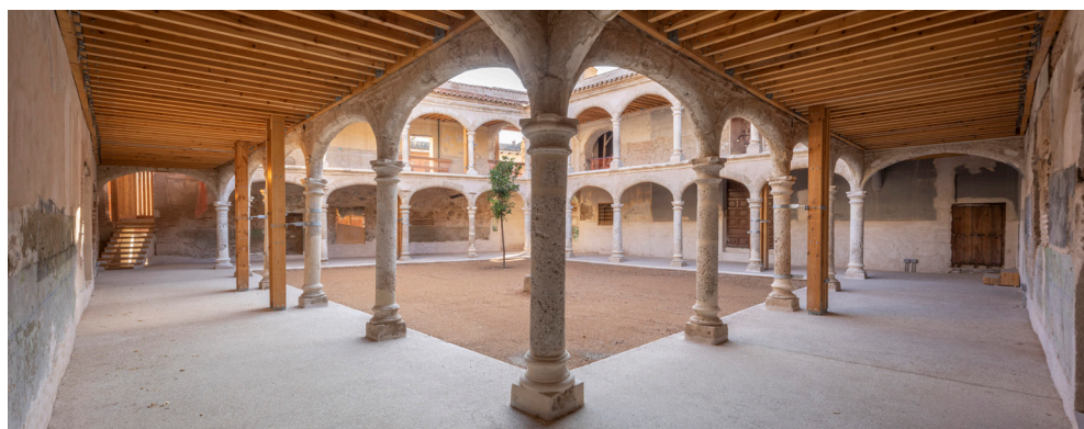
FIGURA 5. Hospital de la Santísima Trinidad. Claustro, esquina SO: antes, durante y después de los trabajos de rehabilitación. Imagen: Equipo Torrijos, Javier Longobardo.
