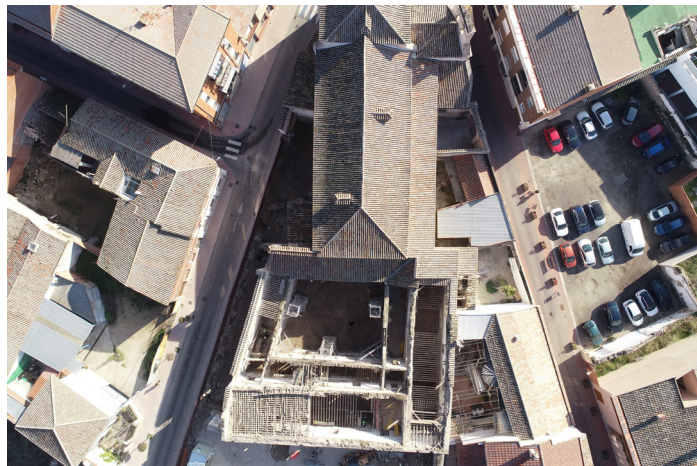
FIGURA 4. Fotografía aérea del hospital de la Santísima Trinidad durante los trabajos de rehabilitación. Imagen: Equipo Torrijos.
