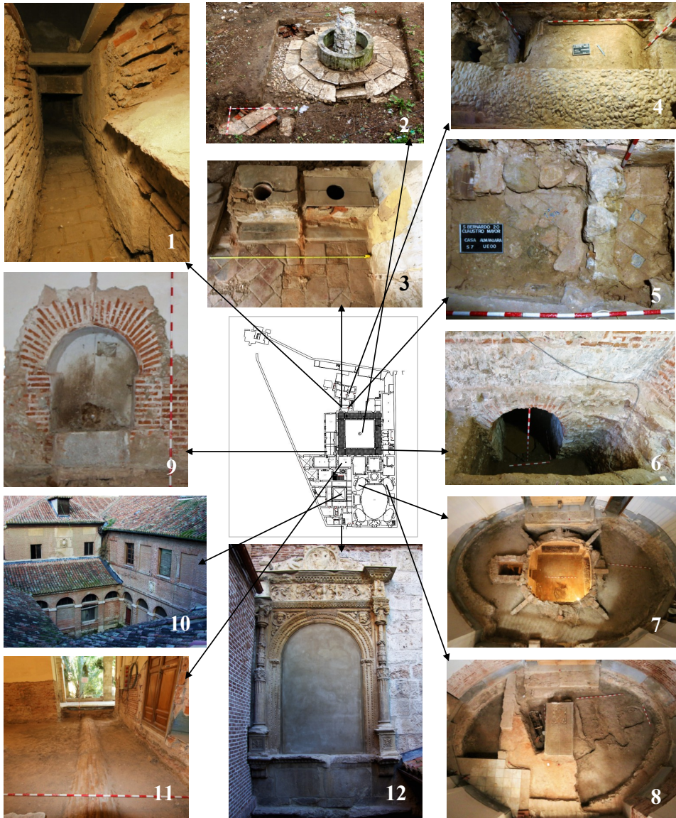
FIGURA 5. Localización de elementos documentados en las intervenciones arqueológicas. 1: Casa de la Almanjara , canal de desagüe de las letrinas. 2: Fuente del claustro mayor. 3: Casa de la Almanjara . Letrinas de planta primera. 4: Casa de la Almanjara , pavimento y galería abovedada de la crujía sur. 5: Casa de la Almajara , pavimento cerámico con olambriillas siglo XVI. 6: Vano de acceso a posible cripta localizado en sondeo 4. 7: Cripta para enterramiento de Luis de Oviedo. 8: Capilla con enterramientos de los capellanes. 9: Pila del lavatorium en aposento común. 10: Vista del claustro menor. 11: Canalización de desagüe. 12: Ventana plateresca de planta primera del palacio arzobispal desde el patio interior de la casa de la Demandadera. Autores: Ana Lucía Sánchez Montes y Juan S. Rascón Sánchez.
