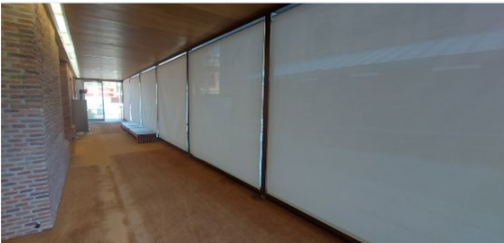
Adquisición de estores como medida preventiva del estrés térmico provocado por las altas temperaturas en el hall acristalado de acceso al ARCM.
