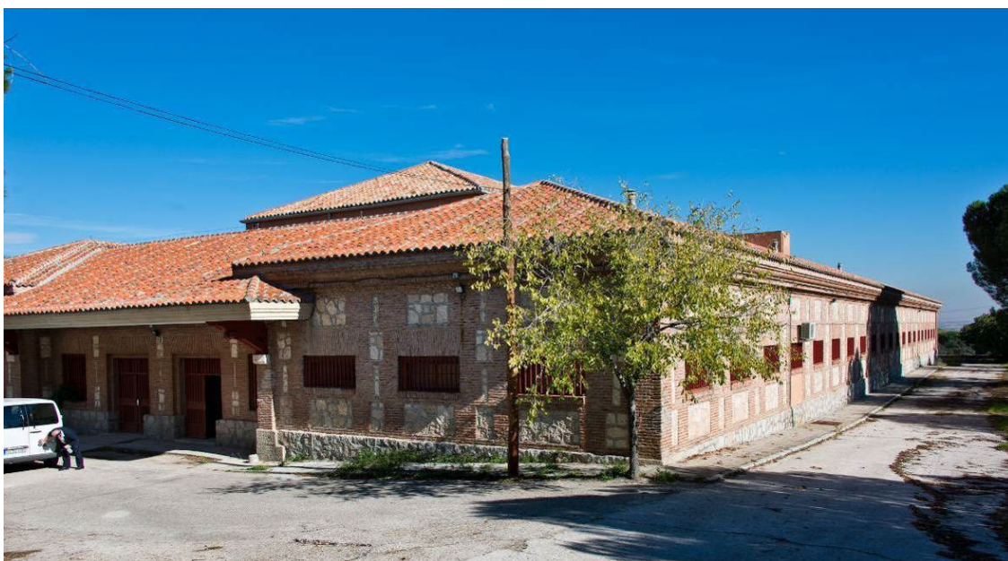
Edificio Matadero del Complejo Ciudad Escolar-San Fernando.
