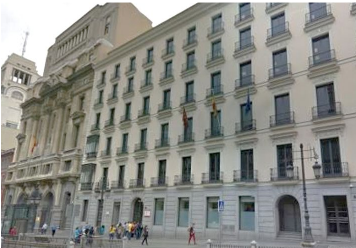
Sede de la Consejería de Educación, Ciencia y Universidades, situada en la calle Alcalá 30-32, donde se ubica el SDAC de Educación, Ciencia y Universidades.
