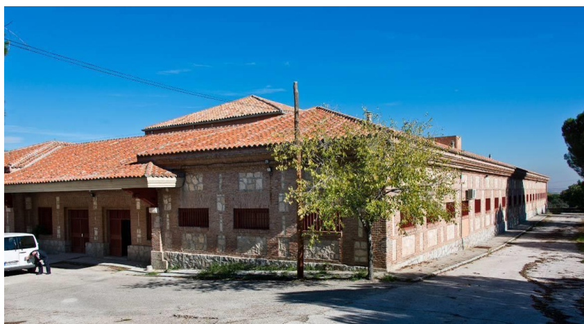
Edificio Matadero del Complejo Ciudad Escolar-San Fernando.
