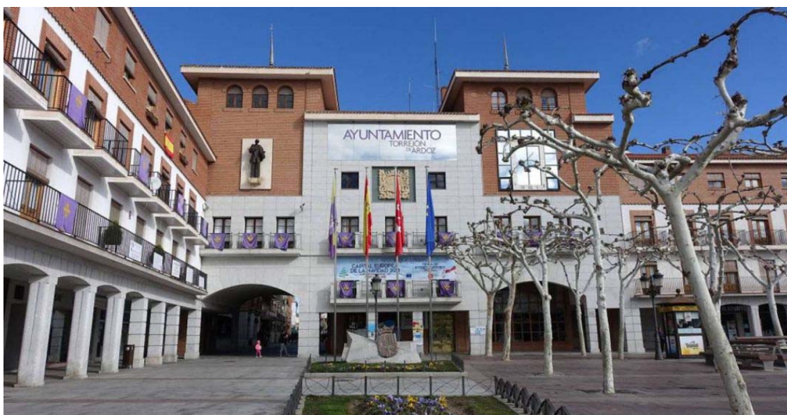
Imagen del Ayuntamiento de Torrejón de Ardoz, uno de los municipios madrileños beneficiados con las subvenciones de 2020.
