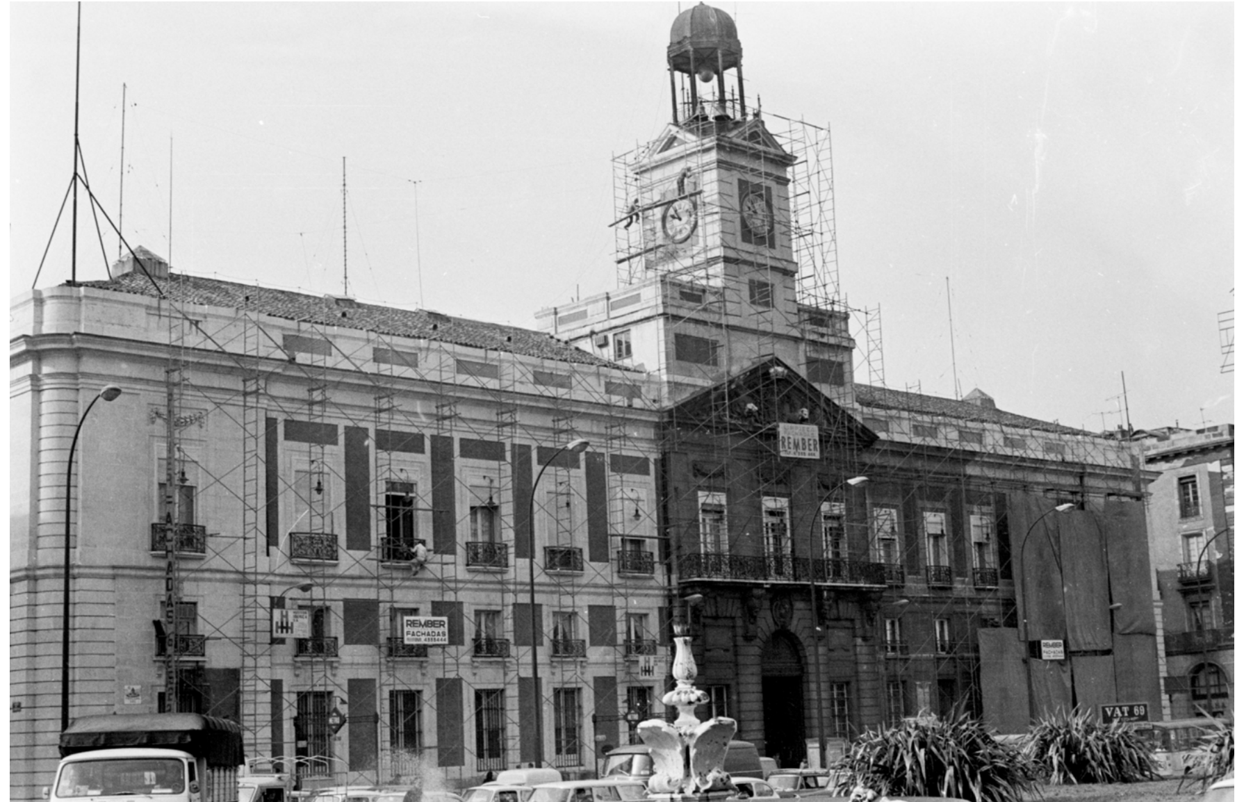
1973. Andamiaje para el revoco de la Real Casa de Correos. ARCM. Fondo Martín Santos Yubero. Signaturas 028854/008 y 003.
